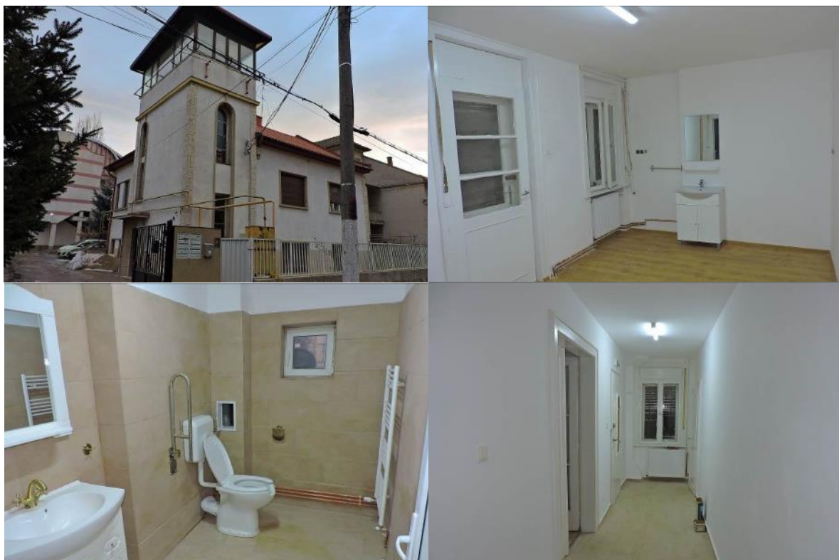
Figura 72. Lucrări de reparații și modernizare la parterul Clinicii Universitare (str. Petre Râmneanțu nr. 11)
