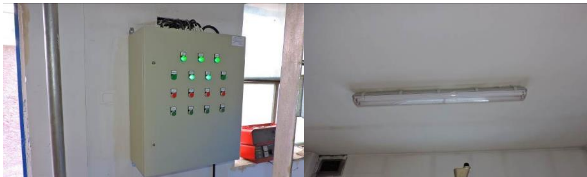
Figura 74. Reabilitarea instalației electrice a căminului C3
