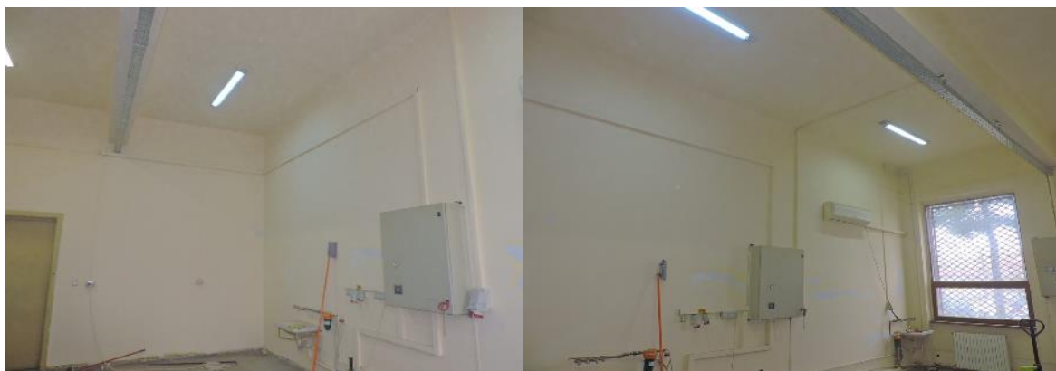
Figura 71. Reparațiile laboratoarelor F004 și F005 ale Facultății de Fizică
