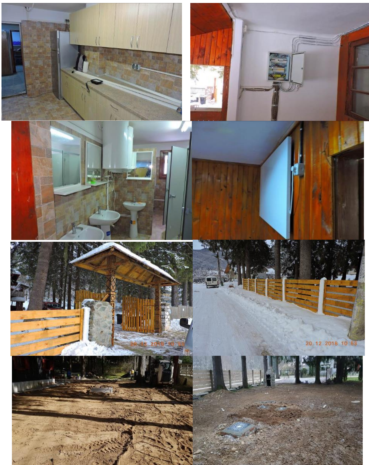
Figura 73. Lucrări de reparații și reabilitare la Centru de practică aplicativă pentru studenți – Vila Bertha din Poiana Mărlui
